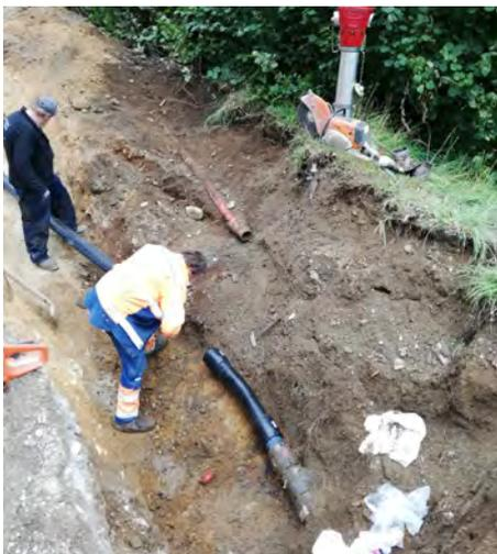
Beim Glasfaserausbau konnten wir dieses Jahr bereits einige Strecken mit dem passenden Multirohrverband ausstatten, zB vom Feuerwehrhaus Partenen bis in den Ortsteil Loch und in der Straße Innerbofa. Auch bei den Grabarbeiten zur Erneuerung der Valschavielbachbeileitung werden Glasfaser-Leerrohre und eine neue Wasserleitung inklusive Hydranten mitverlegt.
